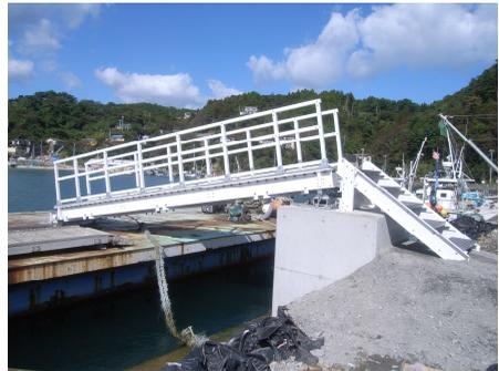
図-4 架設した FRP+UFC 合成桁(渡橋)
