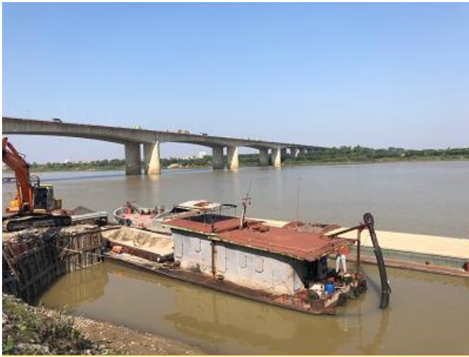
Thanh Tri 建廃処分場からホン川を見た光景。見える橋は Thanh Tri 橋。
