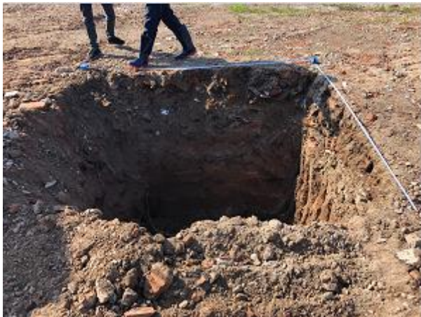
掘削したピット。深さ 2 m。
