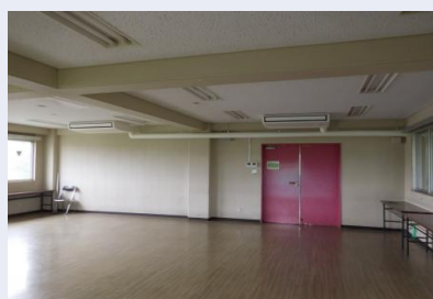
課外活動共用施設(大集会室)のエアコン新設
