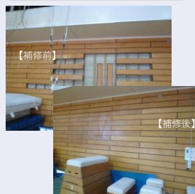
第1体育館内壁の補修
