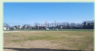
透水管撤去工事
