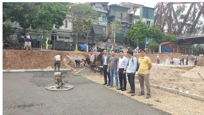
公園グラウンド施工を指示するSATREPSメンバー(中央：HUCEザン副学長)
