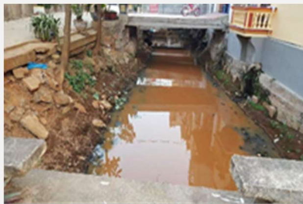
生活排水路に流出した浄水汚泥 （ベトナムハノイ市）
